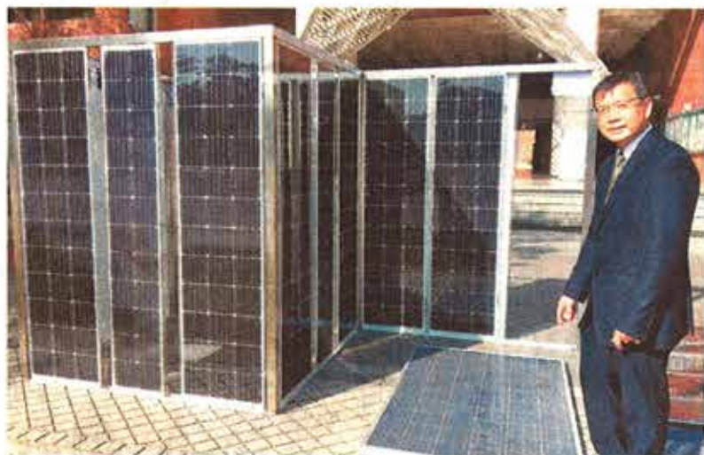
台南大學綠色能源科技學系主任傅耀賢團隊，展示以回收廢舊太陽能光電板搭建的太陽能屋（上圖）及回收的材料。
